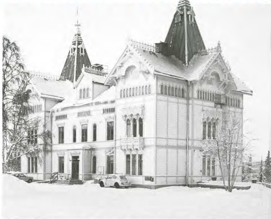
Vid "slottet" Fjällnäs kommer ett nytt stort bostadsområde att växa upp. Drygt 150 lägenheter ska byggas de närmaste åren. Plus ett dussintal småhus vid Wassaragården.
