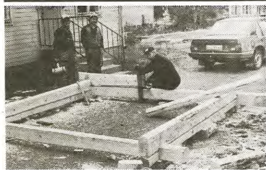
Uppbyggnaden av Västerlånggatan är i full gång. Ett svartbygge tyckte någon och anmälde saken.
