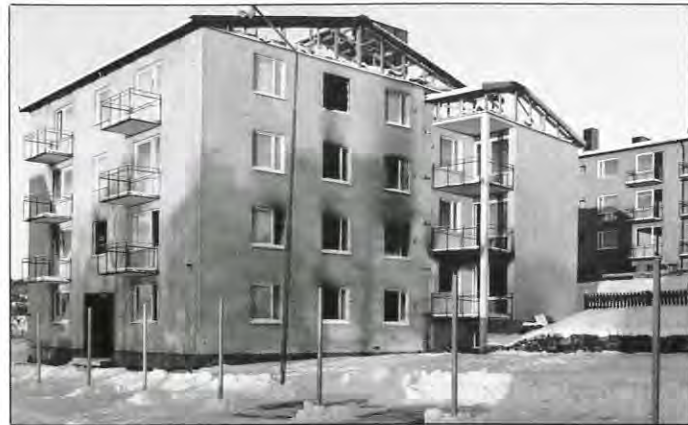
Övningen Nordanvind genomförs i rivningshus vid Gropen i Malmberget.
