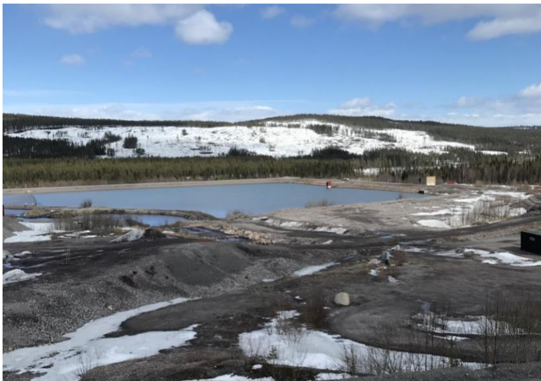
Figur 4.11. Klarningsmagasinet i anslutning till sandmagasinet.
