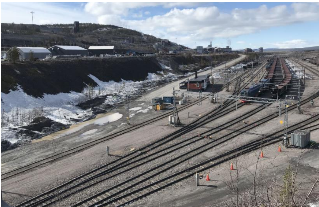
Figur 4.8. Järnvägsspåret ligger central placerat inom utredningsområdet och är beläget på en lägre nivå än det befintliga industriområdet. Den branta slänten från industriområdet ner till järnvägen syns till vänster i fotot.
