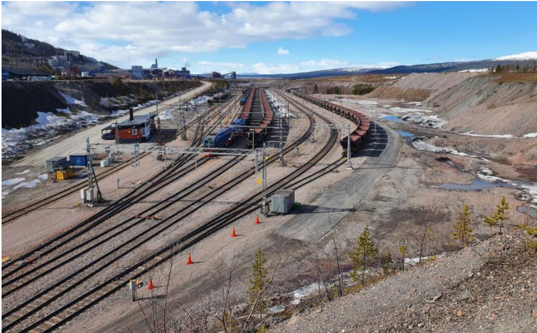
Figur 4.5. Järnvägsspåren med omgivning. Det kan ses i fotot att omgivningen sluttar ned mot järnvägsspåren.
