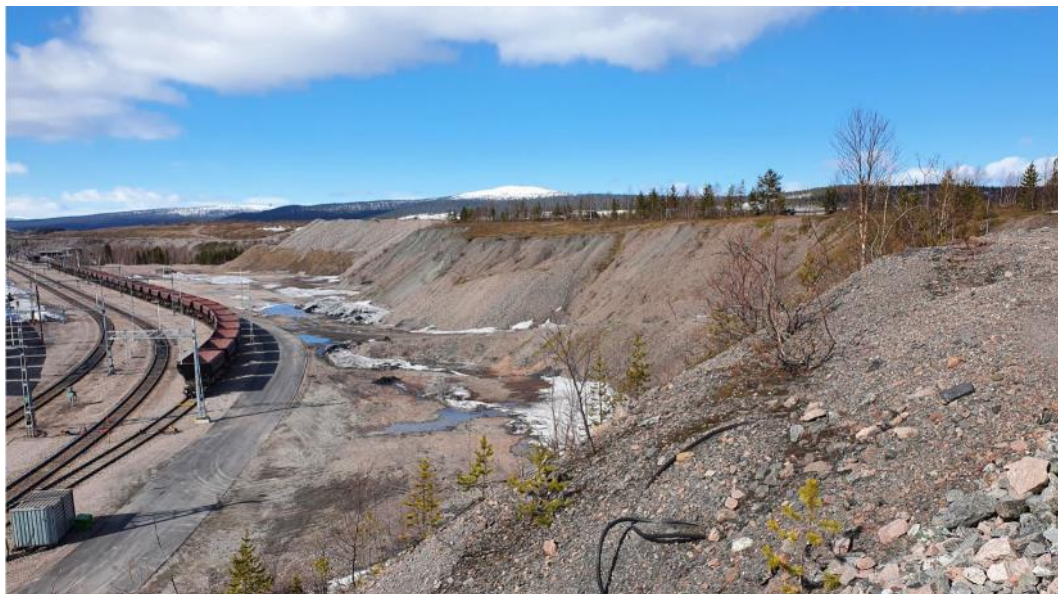
Figur 4.10. Det gamla sandmagasinet i utredningsområdets östra del, samt slutning ner mot spårområdet.
