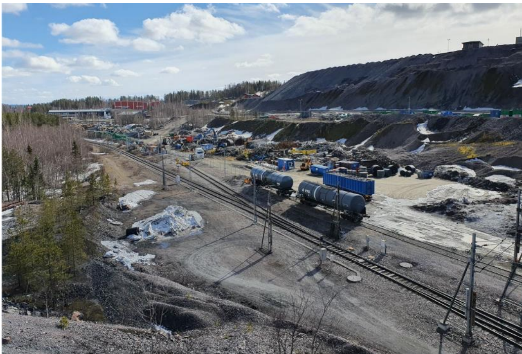
Figur 4.6. Järnvägsspåret där LKAB skickar sina produkter vidare ut i världen.
