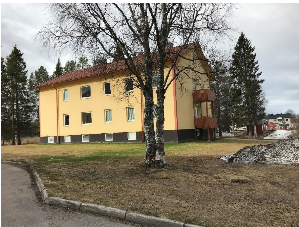
Figur 10: Byggnad i den västra delen av planområdet.
