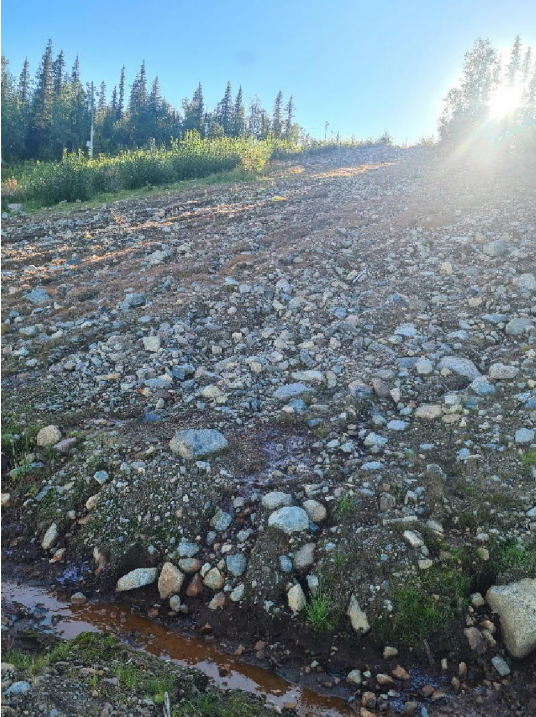
Figur 4 Skidbacke med pågående erosion där ingen återetablering av växtlighet ännu skett efter markplanering
