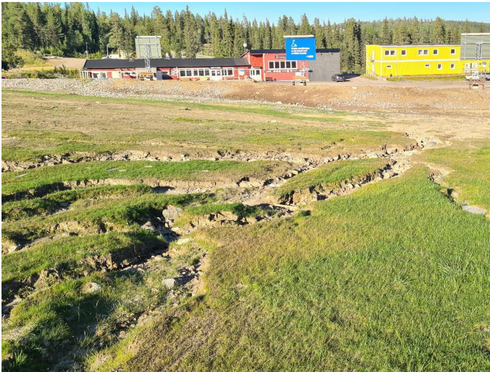
Figur 3 Erosionsfårar i nedre del av slänt
