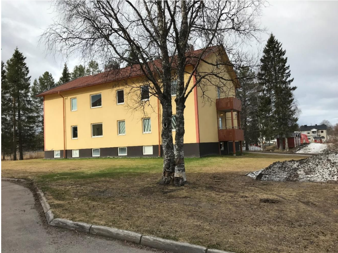
Figur 10: Byggnad i den västra delen av planområdet.
