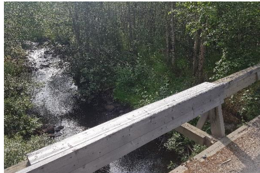
Bild 2. Vy mot autobox vid lokal 4.
