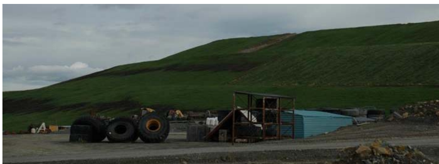
Figur 68. Vy mot sydöst över den delvis efterbehandlade östra gråbergsdeponin i Aitik.
