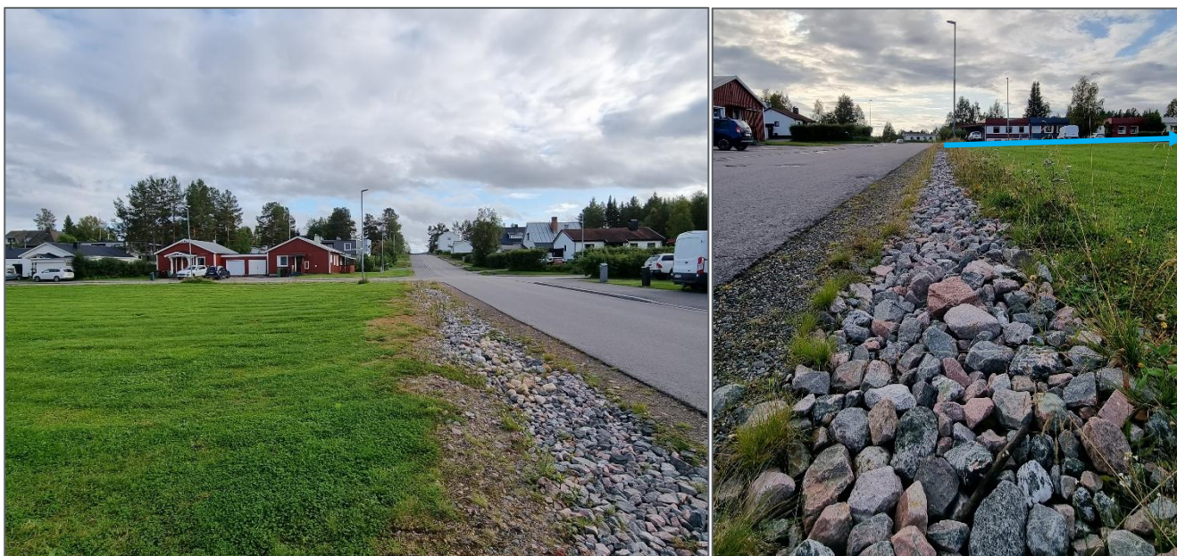
Figur 7. Krossmaterial längs planområdets södra gräns i anslutning till Egnahemsvägen. Blå pil visar var krossdiket viker av norrut längs Laestadiusvägen.
